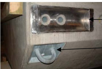
Rakkoppling W300 - här monteras vajer och gummidämpare Förankringsbygel
